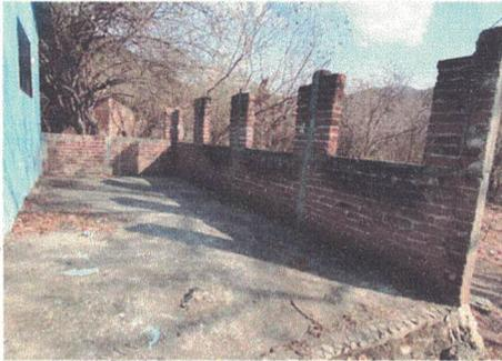
Foto 3: Sustitucion piso cemento liquido, reparacion muro perimetral block, fabricacion puerta de rejas, instalacion de estructura portante de metal, cernido en muro, y aplicacion de sabieta muro de contencion
