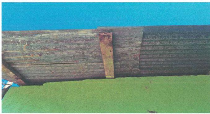
Foto 1: AVILA 2 PREPRIMARIA, DAÑOS EN TECHO DE LAMINA Y MADERA.
