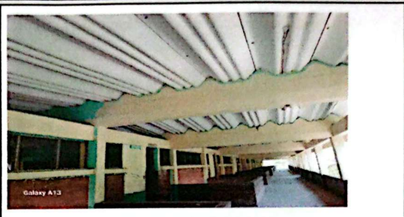
Foto 2: Sustitución de estructura de soporte.
