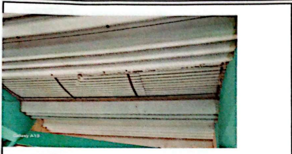
Foto1: Sustitución de lámina.
