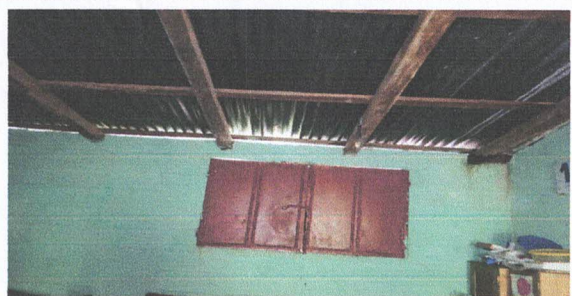
Foto 2: Sustitución de estructura de soporte y lamina.
