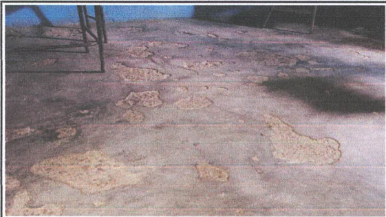
Foto 3: Sustitución de torta de concreto liso en aulas.
