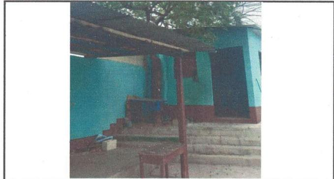
Foto 2: Reparación de Cocina. (Sustitución de hornillas para leña, Campana metálica para hornillas de leña, repisas de concreto para cocina, tabiques de block, Reubicar acceso a cocina, reubicar puerta y ventana y Pintura a paredes de Cocina).
