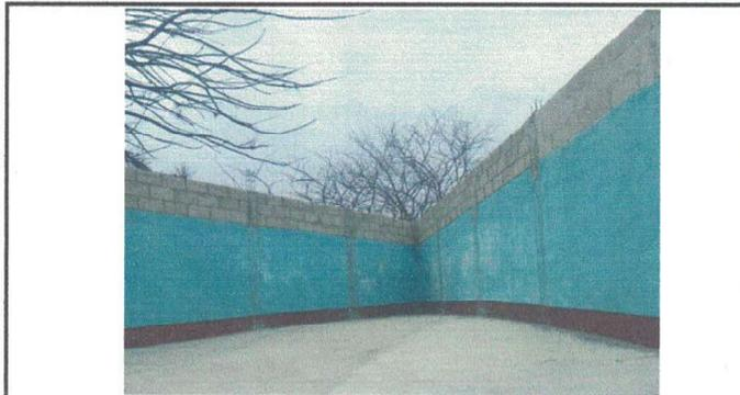
Foto 3: Reparación en Muro Perimetral. (Repello, Cernido y aplicación de pintura en interiores y exteriores; y Rotulo de la Escuela).
