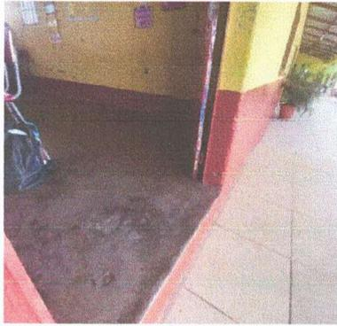
Foto 1: Reparación de Piso, Sustitución de piso de concreto por piso ceramico, en area de Aulas Parte Interna
