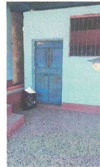
1.13 mantenimoiento a puerta de metal
