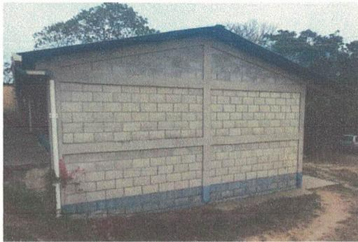
Foto 1: Lámina Acanalada en Mal Estado, debido a que es una DONACIÓN de una ONG y la misma por las características bajas: NO CUMPLEN NORMAS Y ESPECIFICACIONES DE OBRA DE MINEDUC.
