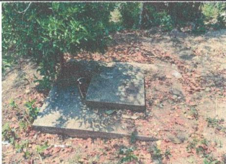
Foto 5: Tratamiento de Saneamiento Ambiental. Mejorar la Fosa Septica y Pozo de Absorción Colapsado.
