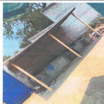
Remozamiento de techo en Pila, reemplazo de madera por metal y agrandar techo 5.5 x 5.5 mts (Suministro e instalacion) ✓
