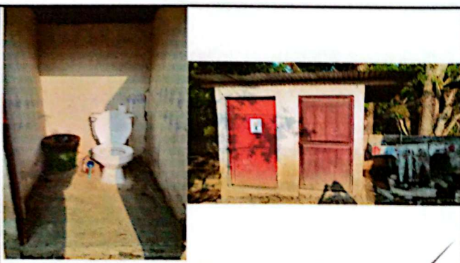
Foto 5: Sustitución de inodoro, instalación de azulejo.
