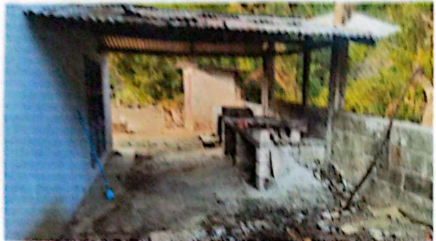
Foto 1: Sustitución de lámina, por lámina aluzinc calibre 26.
