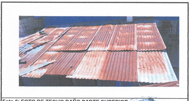
Foto 6: FOTO DE TECHO BAÑO PARTE SUPERIOR
