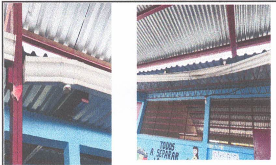
SUSTITUCIÓN DE CANAL POR CANAL DE PVC
