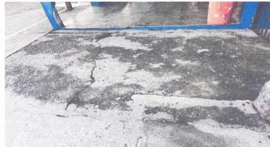
REPARACIÓN DE PLANCHA DE CONCRETO DE PATIO
