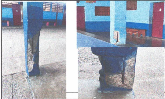
SELLADO DE GRIETAS Y FISURAS EN LOS MUROS
