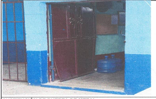
SUSTITUCIÓN DE PUERTA DE METAL
