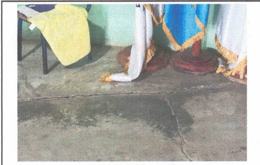
SUSTITUCIÓN DE PISO POR PISO CERÁMICO
