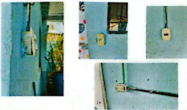
Foto 5: instalación de unidades fuerza
