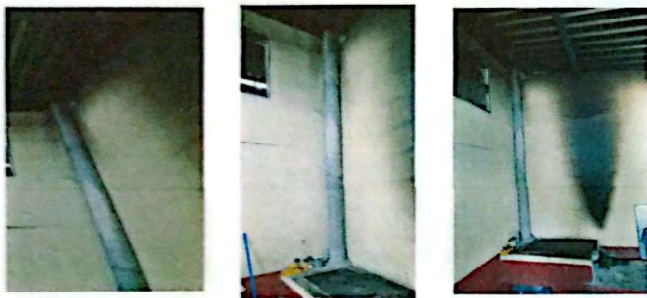
Foto 3: reparación de chimenea de concreto
