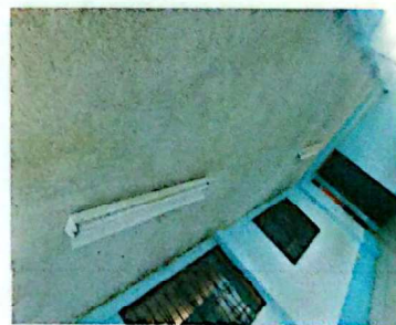
Foto 6: sustitución de focos ahorradores
