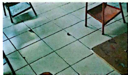
Foto 6: sustitución o instalación de piso cerámico
