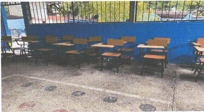
Foto 3: Sustitución de torta de cemento por piso ceramico
