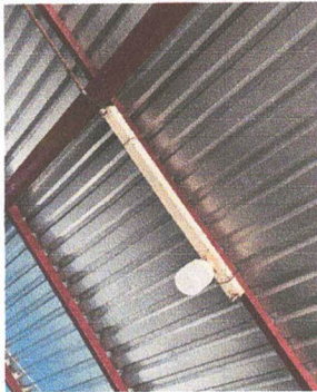
Foto 3: Reparación de sistema eléctrico
