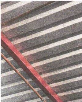
Foto 5: Reparación de sistema eléctrico
