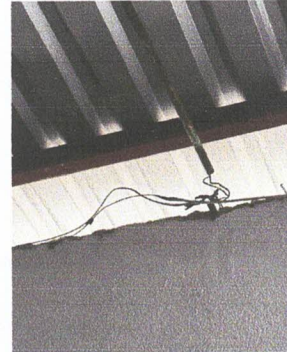
Foto 4: Reparación de sistema eléctrico
