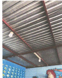
Foto 6: Reparación de sistema eléctrico
