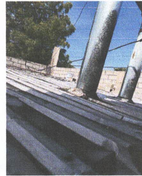
Foto 2: parte de afuera del techo de cocina
