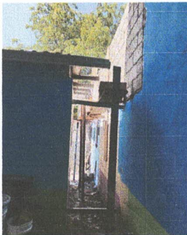
Foto 5: Parte de afuera del techo de cocina
