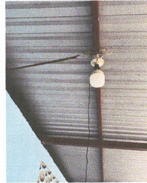
Foto 2: Reparación de sistema eléctrico
