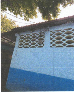
Foto1: Reparación de sistema eléctrico
