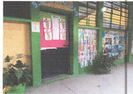
Foto 4: sustitución de puertas de metal
