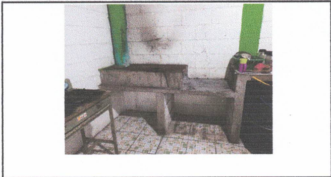
Foto1: Sustitución completa de estufa rural
