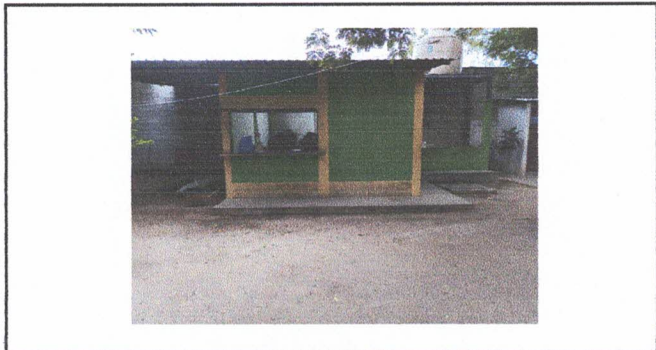
Foto 3: Sustitución de plancha de concreto
