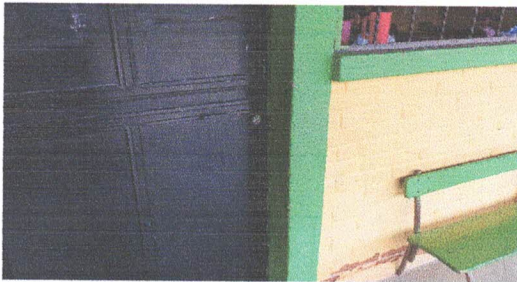
Foto 5: Sustitución de chapa en puera
