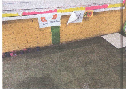
Foto 2: Sustitución de tomafierzas (Tomacorriente, cajas, cable flexitubo y tubo) en cada aula
