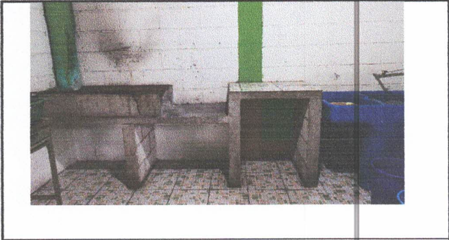
Foto 2: sustitución de mueble de concreto
