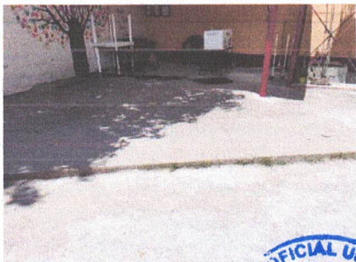
Foto 11: Sustitución de torta de concreto por adyuguin en ingreso
