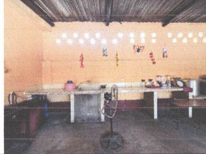
Foto 8: Pintura en muros
