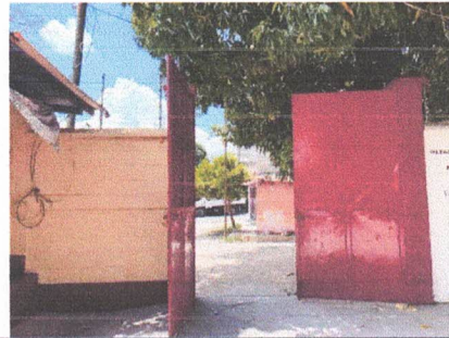
Foto 10: Instalación de estructura metálica en ingreso
