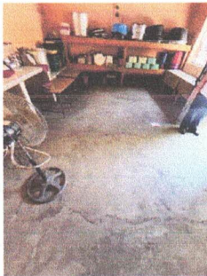
Foto 9: Sustitución de piso de cemento por cerámico antideslizante
