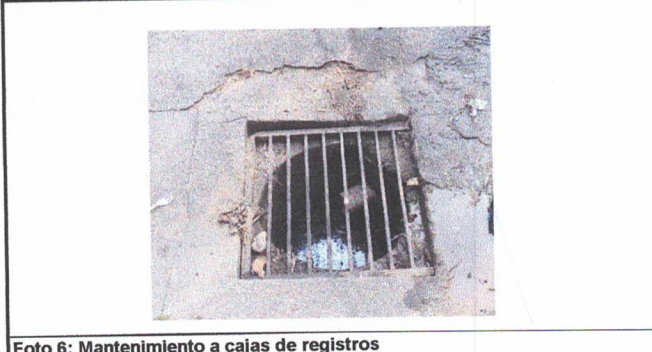
Foto 6: Mantenimiento a cajas de registros
