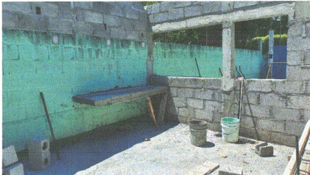
Foto 9: MODULO COCINA. 5.12 Instalación de pila plastica de dos lavaderos
