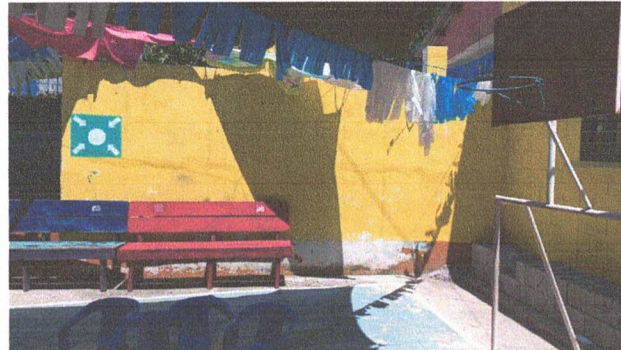
Foto 14: 13. Pintura en muros exteriores (muros)
