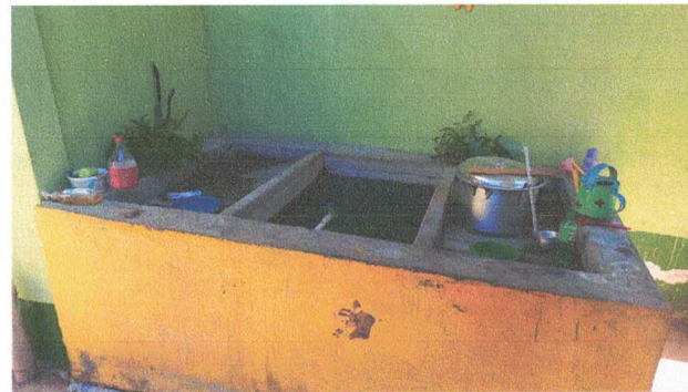
Foto 16: 14.1 Sustitución de azulejo en pila principal de abastecimiento de agua
