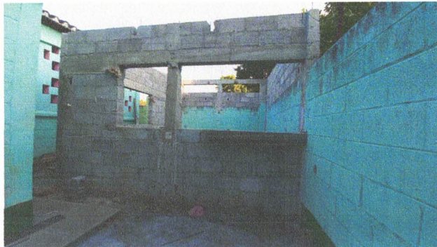
Foto 3: MODULO COCINA. 3.1 Sustitución de canal de metal. 3.2 Sustitución bajada de agua.
