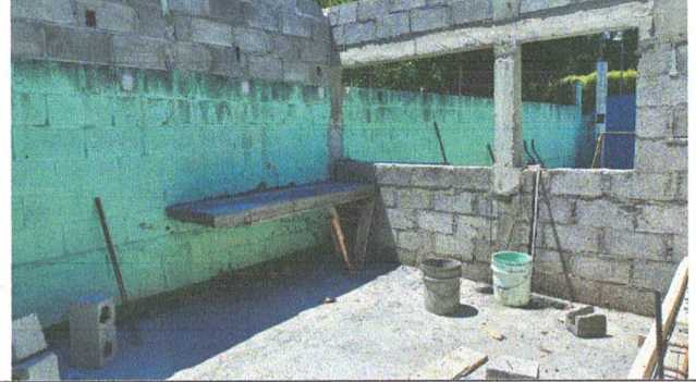
Foto 2: MODULO COCINA 2.1 Sustitución e instalación de azulejo en torta de concreto
