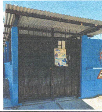
Foto 12: 9.1 Mantenimiento a portón de ingreso
