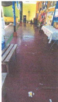
Foto 13: 12.1 Sustitución de piso de cemento liquido por cerámico
