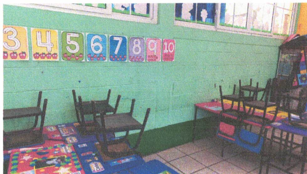
Foto 15: 13. Pintura en muros exteriores (salones de clases)
