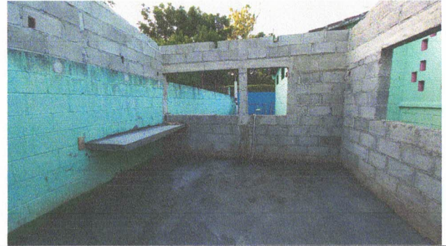
Foto 10: MODULO COCINA. 7.1 Cernido de muros interiores y exteriores.
