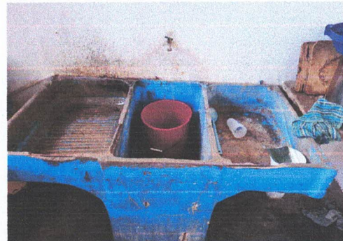
Foto. 6. Sustitución de pila de block fundido de dos lavaderos
