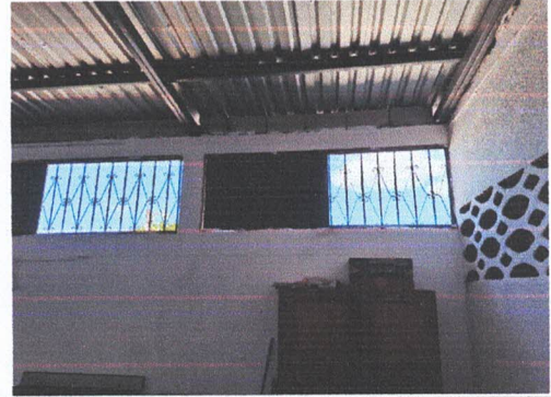
Foto 2: sustitucion de estructura de metal elevado
