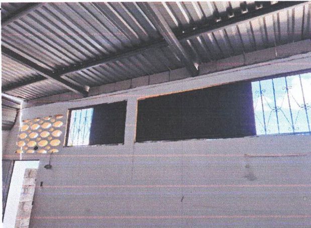
foto 3. Sustitucion e instalacion de balcones de metal
