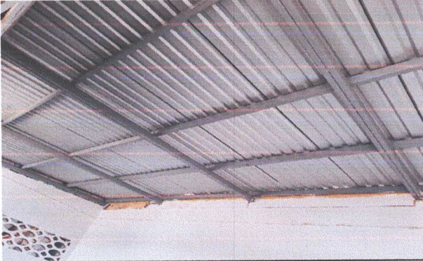
Foto:1. Instalacion de cielo falso
