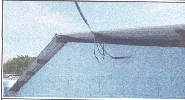
Foto 1: Levantado de muro subir dos hiladas de block al techo del aula.
