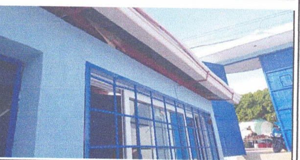
Foto 6: Sustitución de canal PVC por canal de metal
