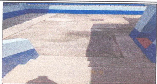
Foto 2: Instalación de piso en patio.
