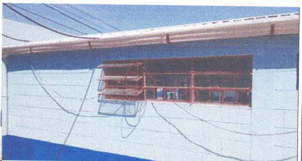
Foto 4: Sustitución de ventana de PVC
