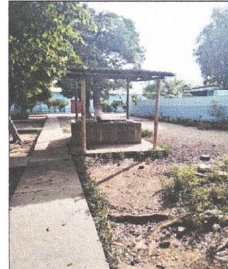
FOTO 2: SUSTITUCIÓN DE ESTRUCTURA DE SOPORTE Y LAMINA.
