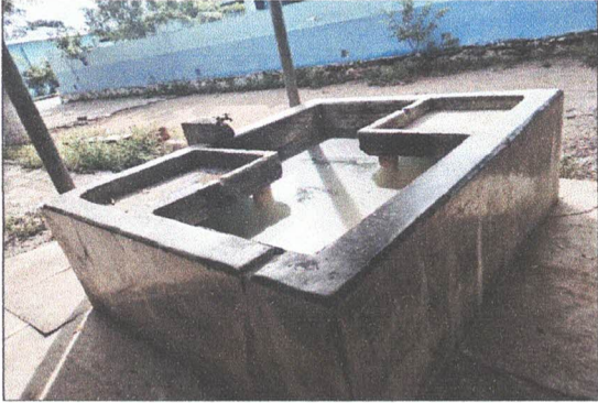
FOTO 1: SUSTITUCIÓN DE PILA DE CONCRETO.
