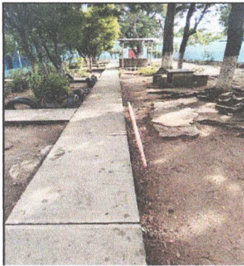
FOTO 3: SUSTITUCIÓN DE TUBERIA DE DRENAJE Y TUBERIA PVC.
