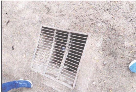
FOTO 5: INSTALACION DE REGILLA PARA TUBERIA DE AGUAS SERVIDAS.
