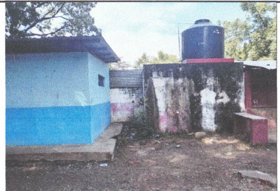
FOTO 6: REPARACION Y MANTENIMIENTO DE CISTERNA / DEPOSITO DE AGUA.
