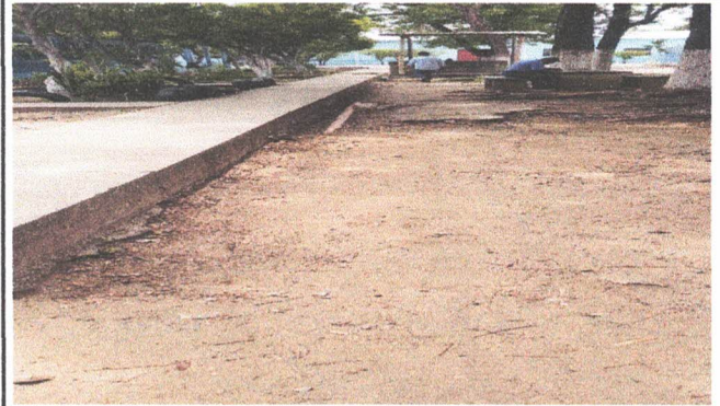
FOTO 4: SUSTITUCIÓN DE PLANCHAS DE CONCRETO.
