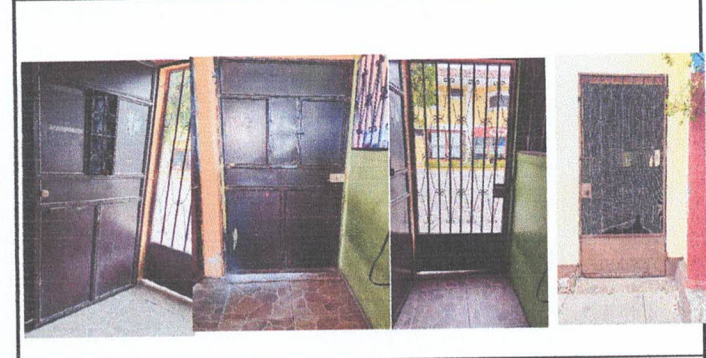
Foto 22: Sustitucion de chapa para puertas de metal marca Yale
