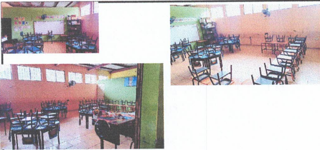
Foto 15: Suministro e instalación de ventiladores de pared de buena calidad
