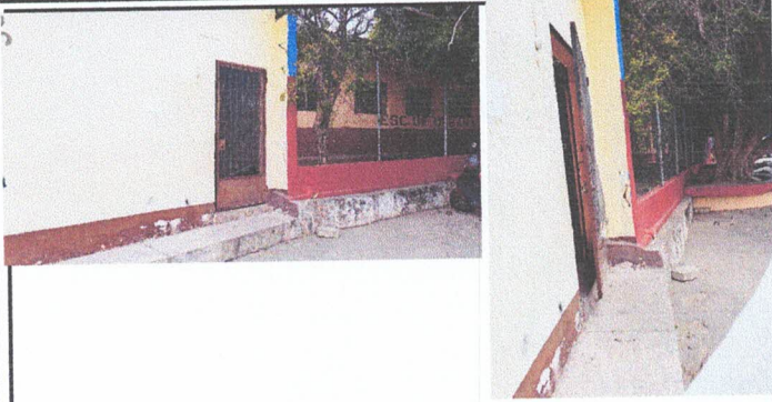
Foto 19: Reparación de cernido en paredes exteriores (zócalo y columna)
