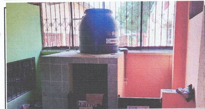
Foto 6: Suministro e instalacion de bomba hidroneumatica de 1/2 HP con tanque de 24 litros en tinaco existente.
