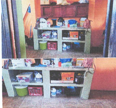
Foto 8: Suministro e instalacion de azulejo en gabinete de concreto, suministro e instalacion de puertas de pvc color blanco en area de gabinete.
