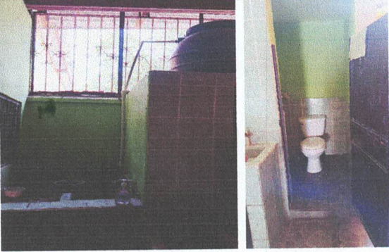
Foto 7: Suministro e instalacion de tuberia principal de pvc en tinaco a area de sanitarios y pila
