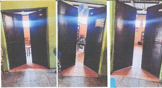
Foto 9: Mantenimiento de puertas de metal.(son doble hoja 1.20*2.10)
