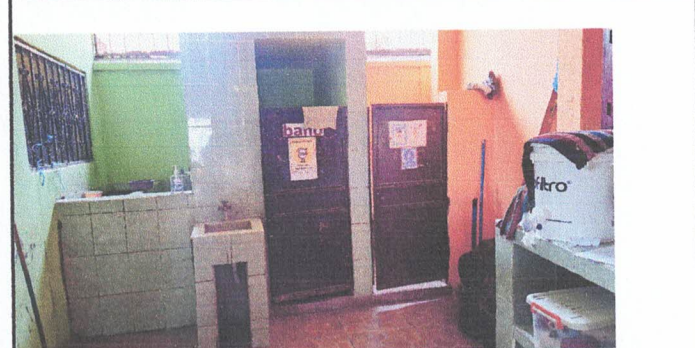
Foto 4: Mantenimiento a puertas de metal (lijado y pintado)
