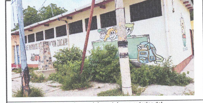
Suministro e instalacion de canal de metal area exterior del establecimiento
