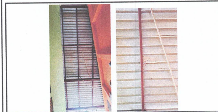
Foto 23: Reparacion de lamina de 3x1 MZ (tapagotera y scilador)
