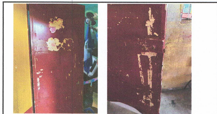
Foto 3: Mantenimiento de puertas de metal y sustitución de chapas de puertas.
