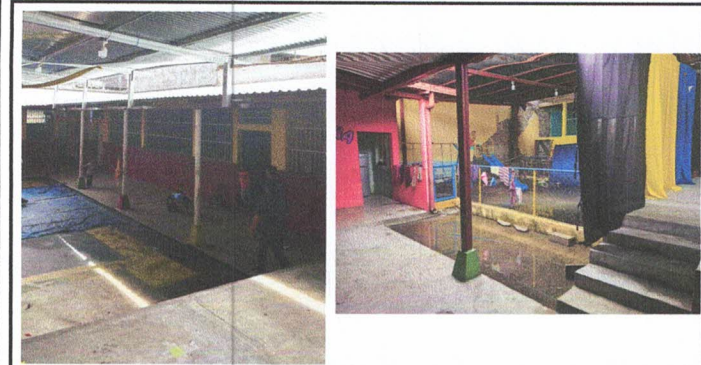
Foto 1: Sustitución de canal de metal para aguas pluviales y sustitución de bajadas de aguas pluviales.
