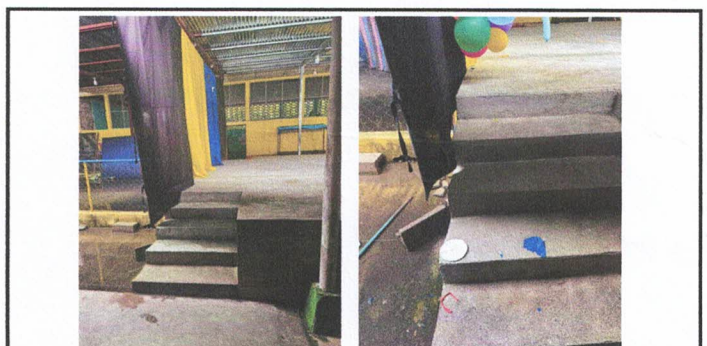
Foto 6: Sustitución de barandas para escenario.
