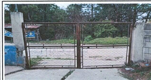
Vista de puerta de entrada principal a remozar.
