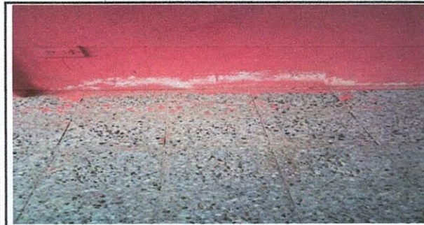
Vista de area de piso de aulas a remozar
