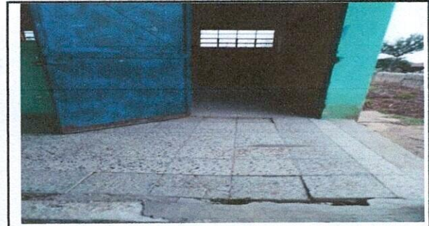
Vista de puertas de aulas a reparar.
