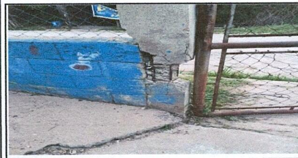
Vista de columnas de concreto a remozar
