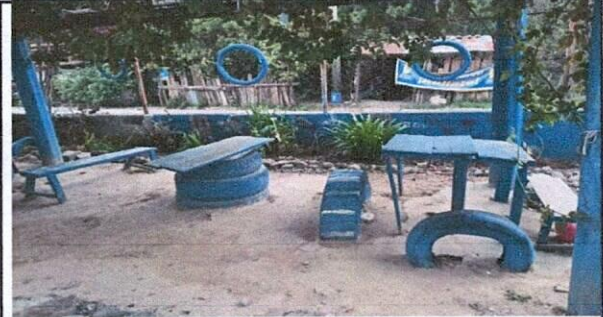
Vista de area de comedor a reparar.
