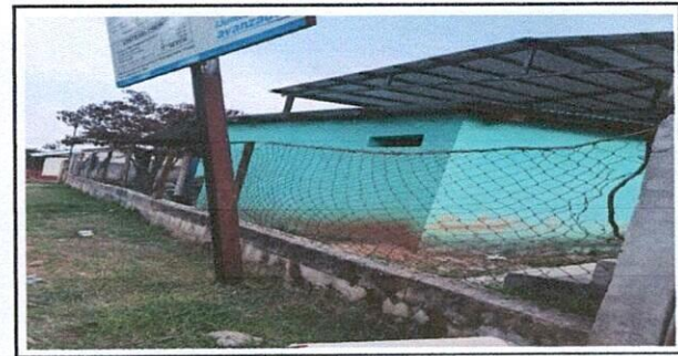
Vista de malla metalica a remozar
