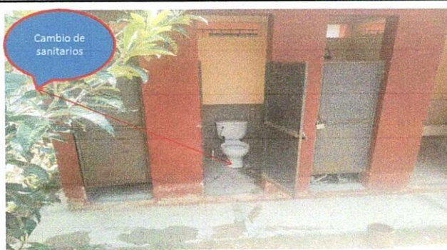
cambio de sanitarios
