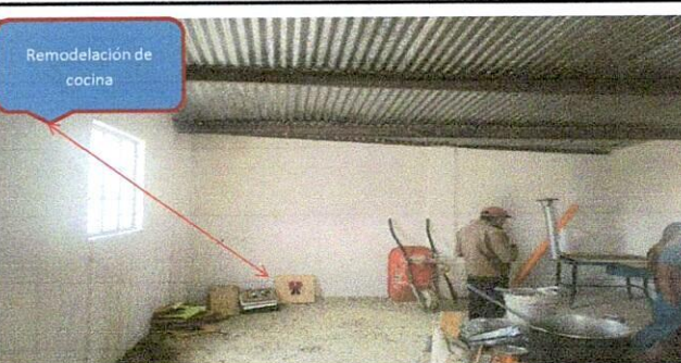
remodelacion de cocina
