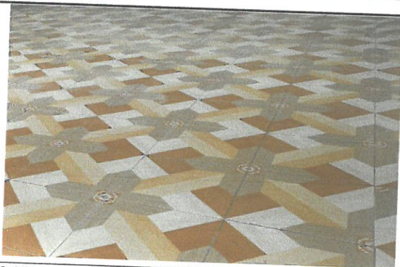
Foto 3: Vista de nuevo piso ceramico
