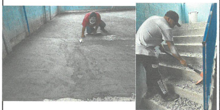
Foto 2: vista de reparación de losa de patio y gradas
