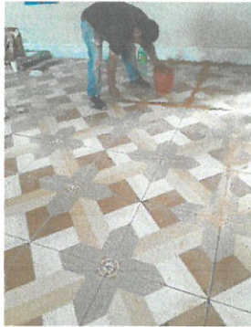
Foto 3: Vista de sustitución de piso
