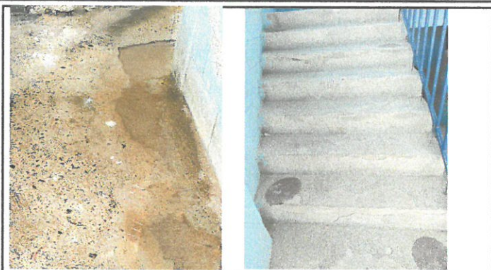
Foto 2: vista de losa de patio y gradas
