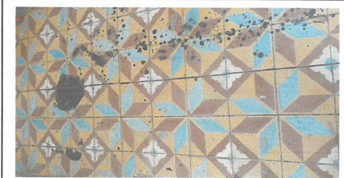
Foto 3: Vista de piso
