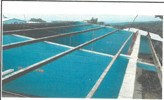
Foto1: Cambio de laminas de dos aulas modulo 1
