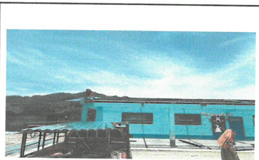
Foto 3: Cambio de lamina modulo 2
