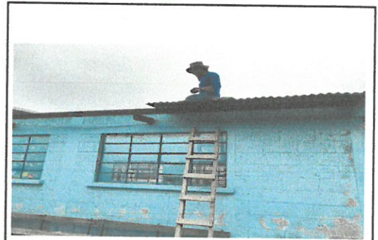
Foto 4: Cambio de lamina modulo 2
