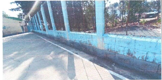
Vista de circulación del establecimiento a remozar.
