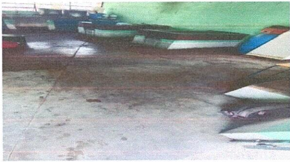
Vista de area de cocina a remozar.
