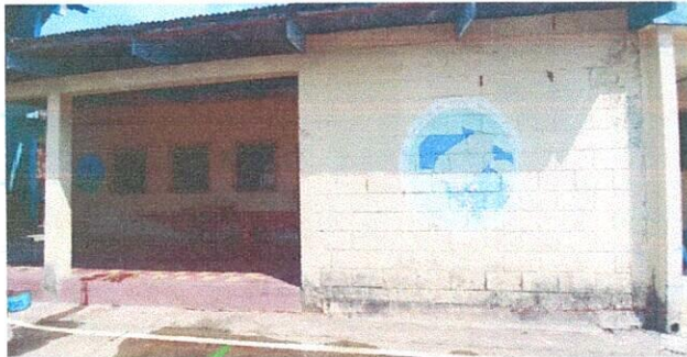
Vista de area de pintura a remozar.
