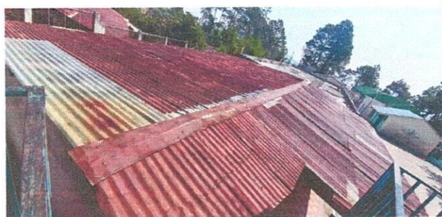
Vista exterior de techo a remozar.
