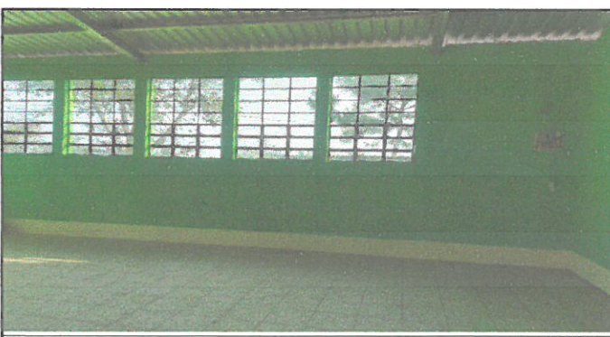
Vista de todas de las aulas en la parte interior ya remozado de la parte interior en la fase posterior de pintura de los módulos 1,2,3 y 4.
