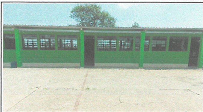
Vista de las paredes y sus puertas de las aulas ya remozados en la fase posterior de pintura en su exterior del módulo 1.
