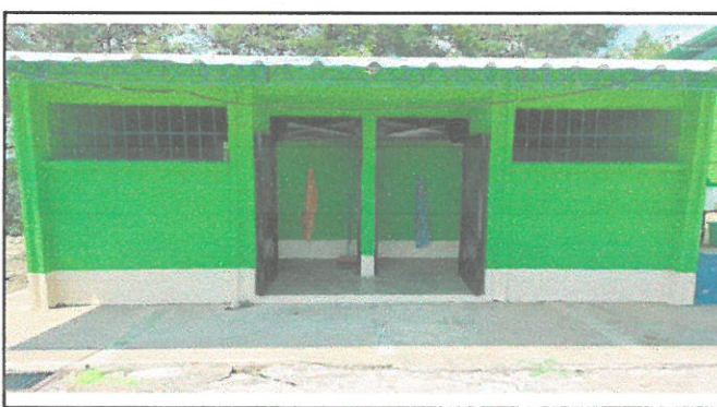
Vista de las paredes y puertas de los servicios sanitarios ya remozado en la fase posterior de pintura.
