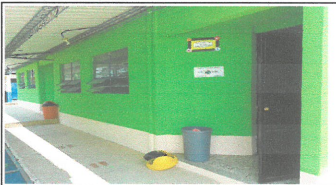
Vista de las paredes y puertas de las aulas ya remozados en su interior y exterior en la fase posterior de pintura del módulo 3.
