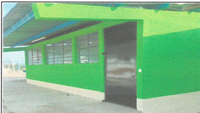
Vista de las paredes y su puerta del aula ya remozado en su interior y exterior en la fase posterior de pintura del módulo 4.
