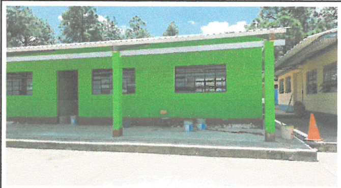
Vista de las paredes y sus puertas a remozar en el proceso durante de pintura en su interior y su exterior del módulo 2
