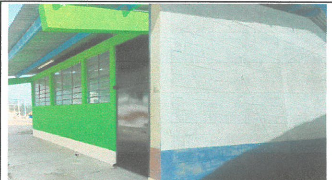
Vista de las paredes y su puerta del aula a remozar en pintura en el proceso durante del módulo 4.
