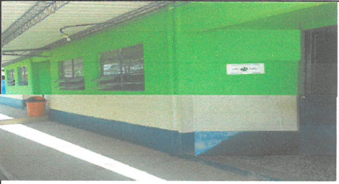
Vista de las paredes interiores de las aulas a remozar en el proceso de pintura en todos los módulos 3.
