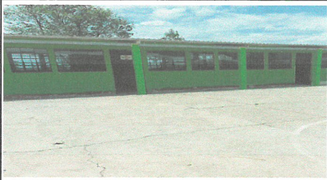
Vista de las paredes y sus puertas a remozar en el proceso durante de pintura en su interior y exterior del módulo 1
