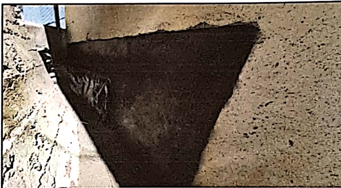
Foto 4: Impermeabilización de paredes en aula de 5to Bachillerato por filtración de agua.
