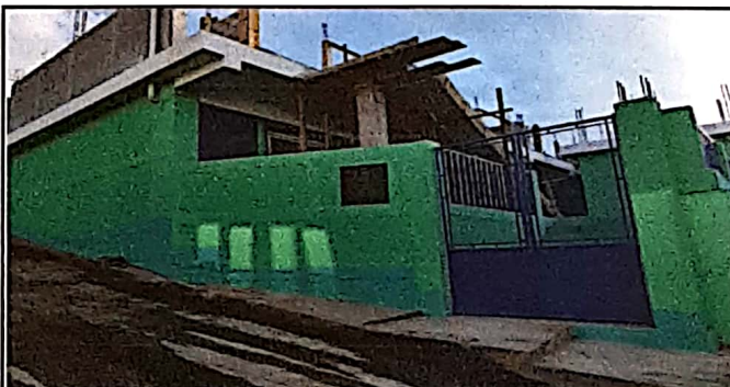
Foto 6: Pintura de paredes interior y exterior
