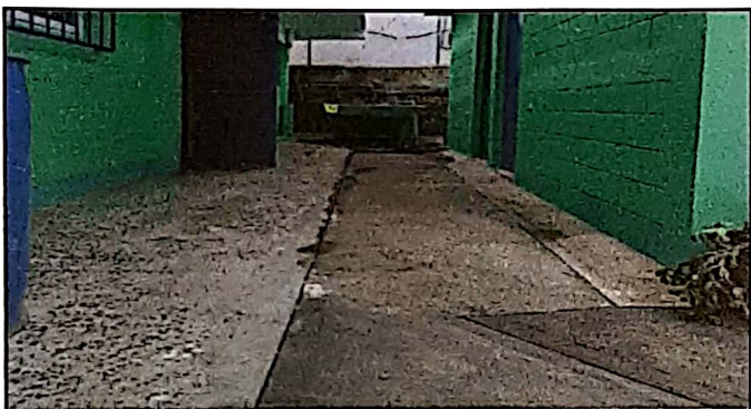
Foto 3: Instalación de drenajes de pila y caja trampa de grasas
