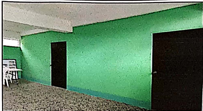
Foto 1: División de ambientes: dirección, bodega y sala de maestros con tabla yeso
