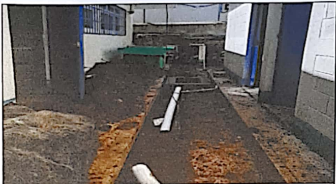
Foto 3: Instalación de drenajes de pila y caja trampa de grasas. En Proceso de Remozamiento 30/10/2024
