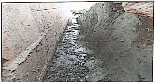
Foto 5: Cuneta de concreto frente a la calle principal. En Proceso de Remozamiento 05/11/2024
