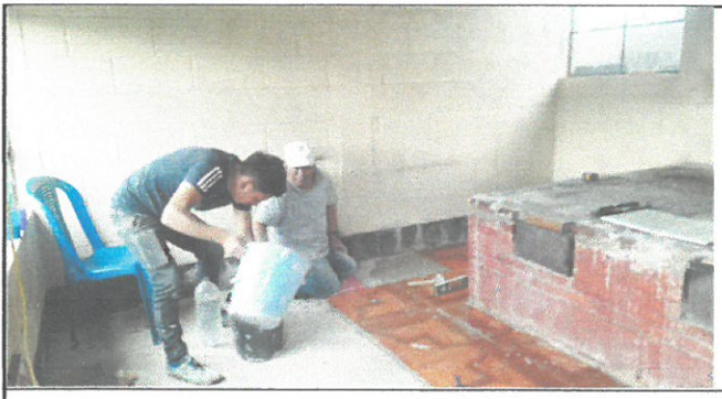
Cambio de piso de cocina y remozamiento de plancha.
