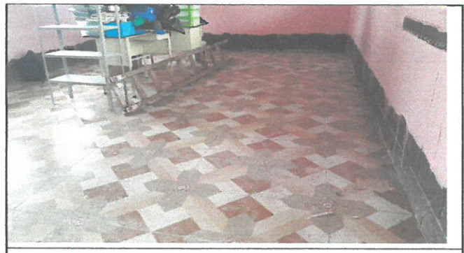
Cambio de piso en aula 1.
