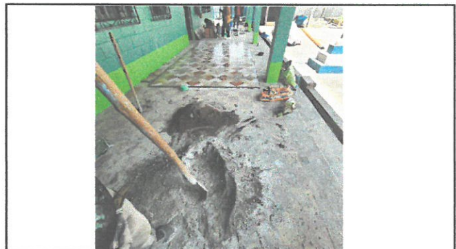
Pintura en corredor de escuela y cambio de piso.
