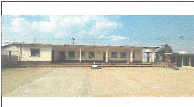
Pintura por fuera de la escuela y cambio de canaletas.
