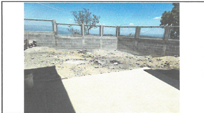
Remozamiento de patio, con 10 cm de espesor.
