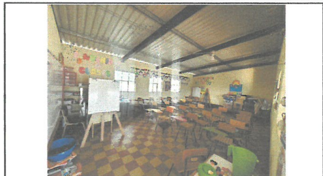
Pintura de aula 1, cambio de piso y cambio de circuito eléctrico.
