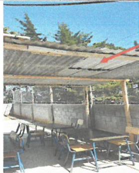
Foto 9: Vista de área a remozar (Módulo 3)
