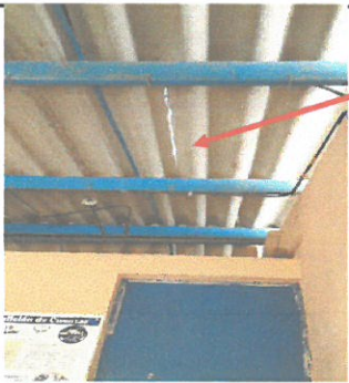
Foto 5: Vista de área a remozar (Módulo 1)
