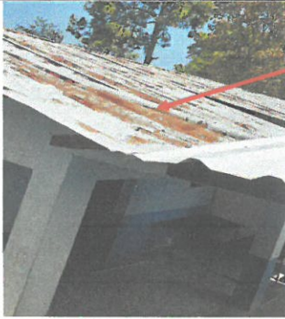
Foto 7: Vista de área a remozar (Módulo 2)
