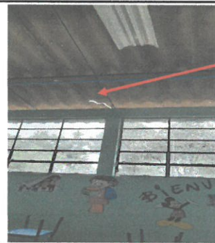
Foto 2: Vista de área a remozar (Módulo 1)
