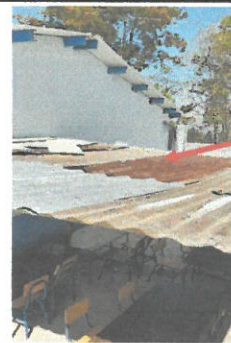
Foto 8: Vista de área a remozar (Módulo 3)
