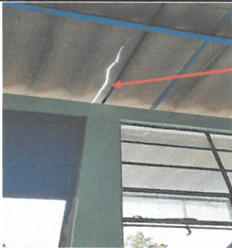
Foto 3: Vista de área a remozar (Módulo 1) .
