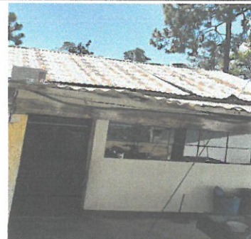
Foto 6: Vista de área a remozar (Módulo 2)
