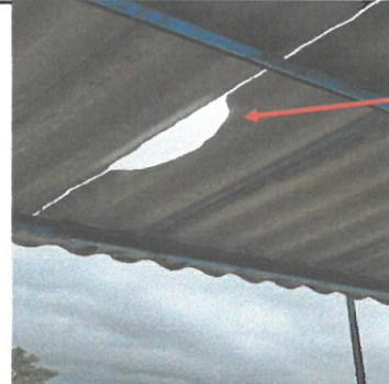
Foto 4: Vista de área a remozar (Módulo 1)
