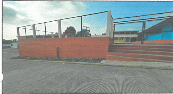
FOTO 1: MURO DE CONTENCION
