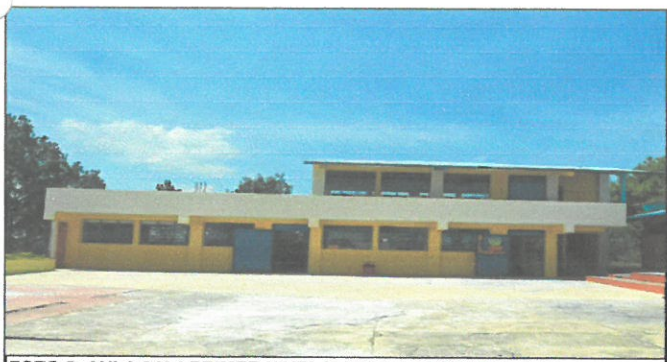
FOTO 5: AULA 3 Y 4 PRIMER NIVEL Y AULA 5 SEGUNDO NIVEL
