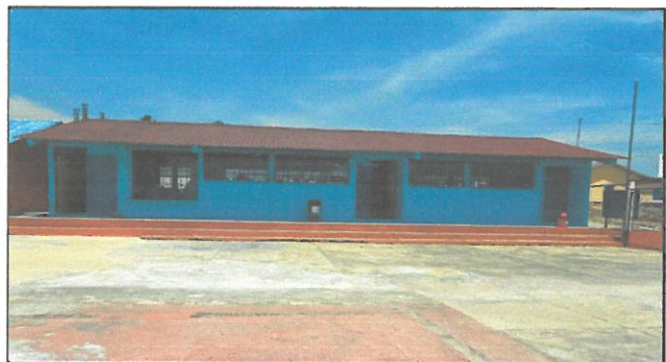
FOTO 4: AULA 1 Y 2 Y COCINA
