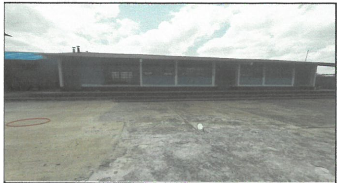
FOTO 4: AULA 1 Y 2, Y COCINA
