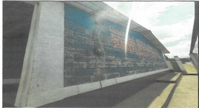
FOTO 2: LATERAL DERECHA AULA 1 POR FUERA
