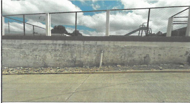
FOTO 1: MURO DE CONTENCION
