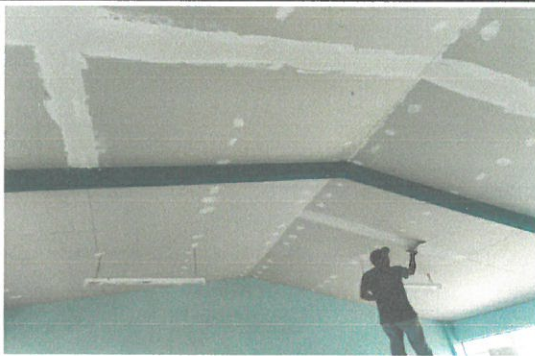
COLOCACIÓN DE CIELO FALSO
