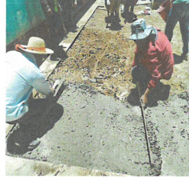
PAVIMENTO DE INGRESO
