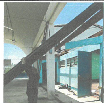
REPARACIÓN DE TECHO
