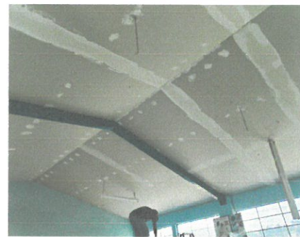
COLOCACIÓN DE CIELO FALSO
