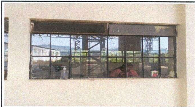
Foto 3: Area de instalacion de balcones
