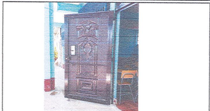
Foto 2: Instalación de puertas al 100% de aula 1.
