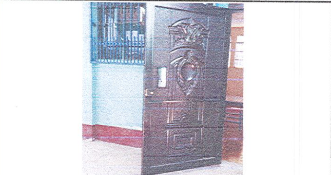
Foto 3: Instalación de puerta al 100% de aula 2.
