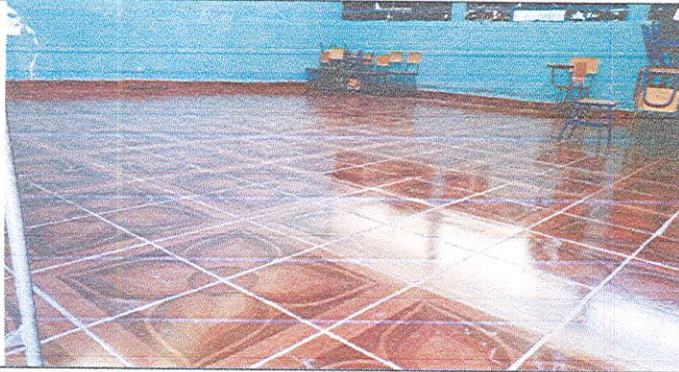
Foto 1: Sustitución al 100% de piso de cemento por piso de cerámico ilustrado en tres aulas y dirección.
