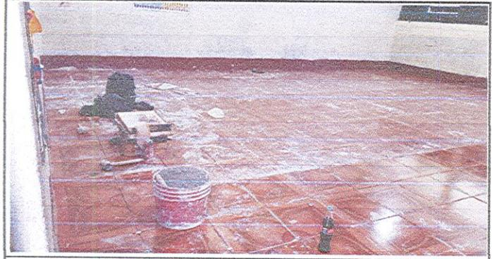
Foto 1: Proceso de sustitución de piso de cemento por piso cerámico ilustrado de aulas y dirección.
