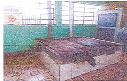
Foto 4: sustitucion de pollo o estufa mejorada con chimenea de ojalata por una estufa de dos ornillos con chimenea de ladrillo
