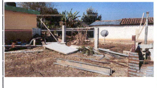
Foto 4: Vista del muro perimetral existente.
