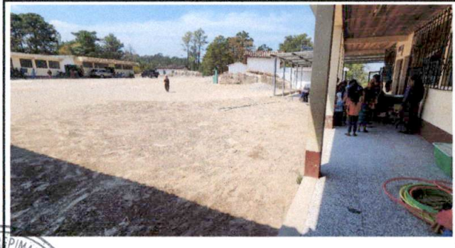
Foto 5: Vista del patio, es necesario colocar una torta de concreto.
