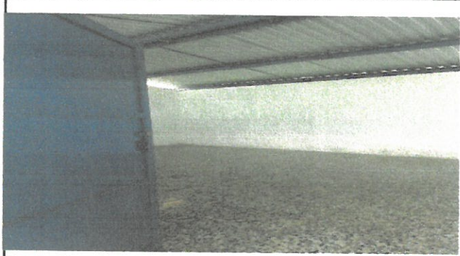
Foto1: Techo del modulo 1
