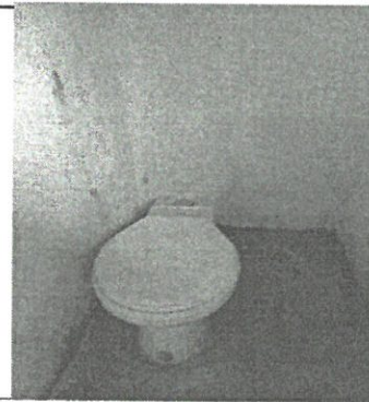
Vista interior de los baños a remozar
