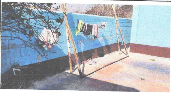
Foto 9: Vista del área donde se colocara un lavamanos de concreto.
