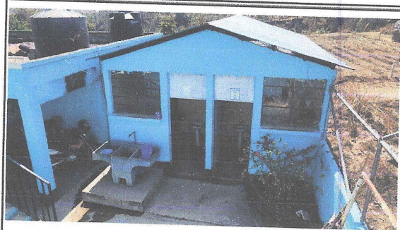
Foto 2: Vista exterior de los baños.
