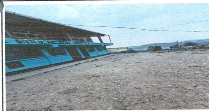
Foto 5: Vista completa del establecimiento pintada incompleta y deteriorada.
